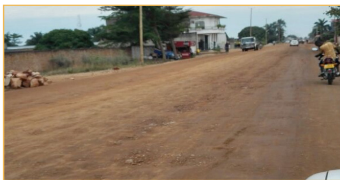
Tronçon manquant de la route Bujumbura-Nyamitanga (32km) se trouve en mauvais état. Les soumissions ont été ouvertes le 19/12/2016. La construction devrait commencer en 2017
