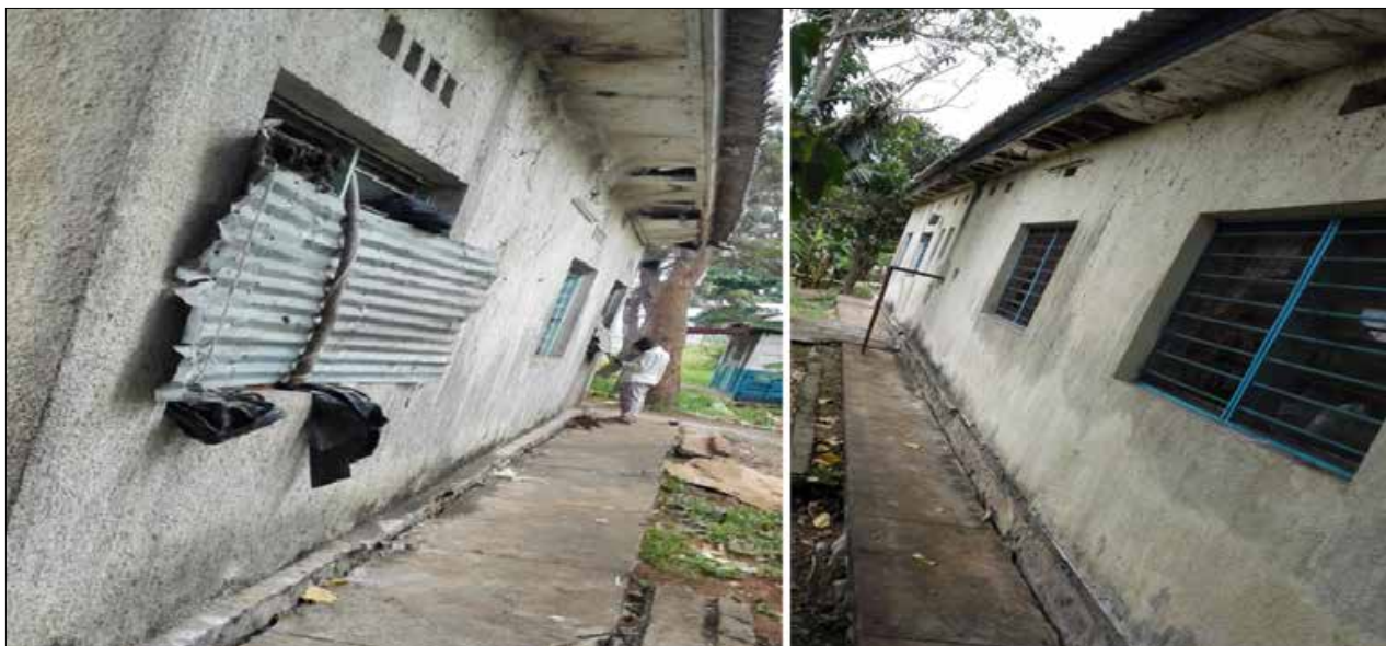
Photo: Poste de Frontière de Gatumba, des bureaux en mauvais état.
