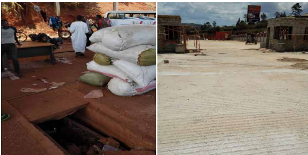
Photo: A gauche: Pont-bascule cassé à Kobero. A droite: Frontière de Kobero en cours de construction.
