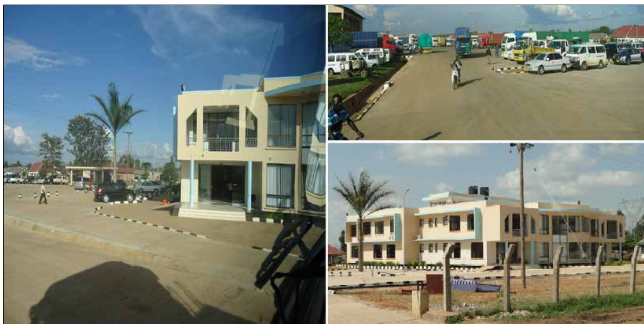
Photo: Bâtiment de l'OSBP à Mutukula (Côté Tanzanien), les officiers sont maintenant en train de travailler basés dans les nouvelles infrastructures malgré que le concept d'OSBP ne soit pas encore mis en œuvre.
